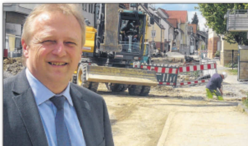
Wolfgang Lahl, Bürgermeister von Weil im Schönbuch, hofft auf eine Sanierung der Hauptstraße bis 2015 ohne große Verzögerungen.
